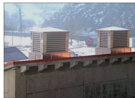
Obr. 9. Větrací věž energetické budovy
