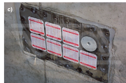
Obr. 9. Průchodky UGA a) připravené k použití, b) vložené do armatury, c) po zabetonování
