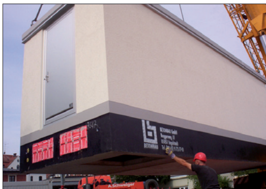
Obr. 5. Průchodky BKD jsou standardem v kioskových trafostanicích
