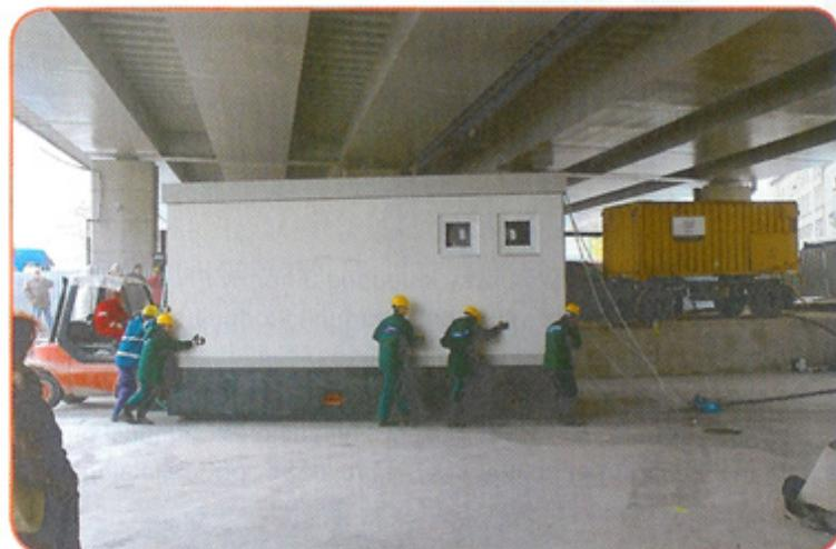
**Kontejner K4** (rozvodna 22 kV AC) je zhotoven v provedení Betonbau typu UF 3072 o vnějších půdorysných rozměrech 7180×3020 mm a celkové základní výšce včetně střechy 3580 mm. Celková hmotnost včetně střechy bez technologie, příček a výbavy je cca 34 t, hmotnost technologie včetně vnitřních stavebních konstrukcí je cca 4 t.
