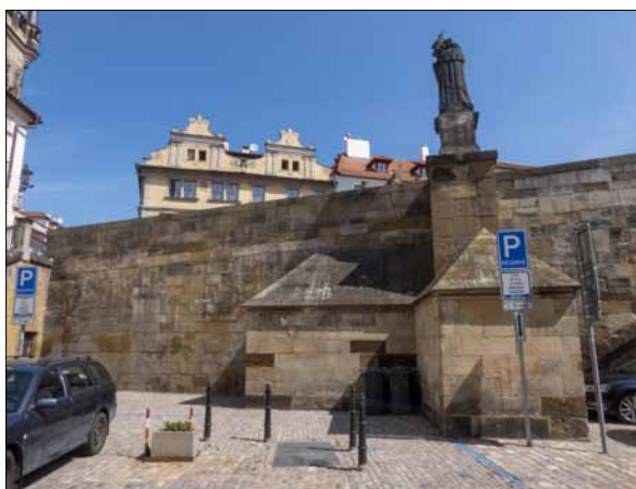
Obr. 3. Místo uložení trafostanice
