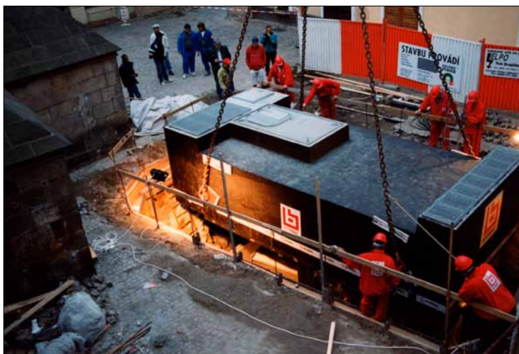
Obr. 8. Ukázka montáže – ukládání horního dílu
