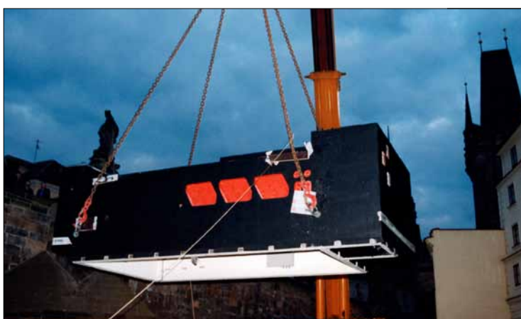
Obr. 5. Ukázka montáže – spouštění dolního dílu
