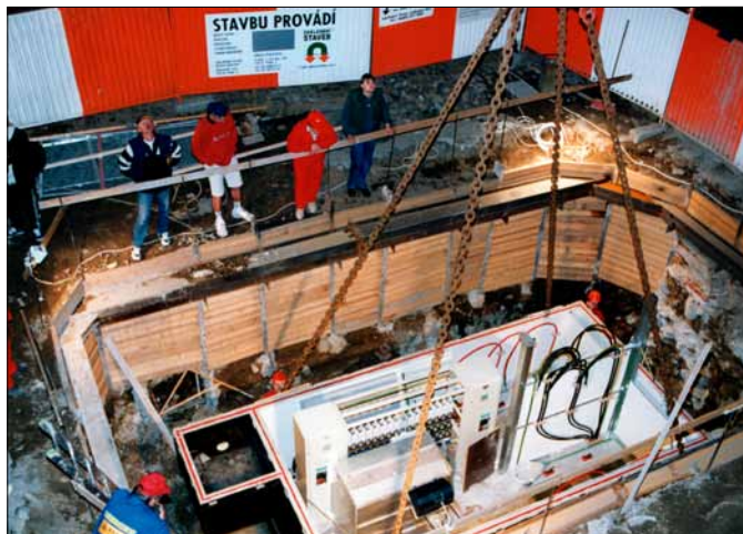
Obr. 6. Ukázka montáže – ukládání spodního dílu
