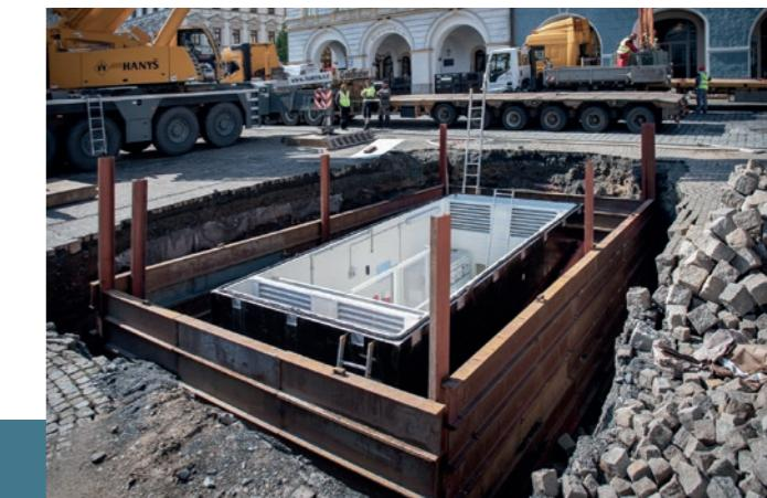
Pro urychlení výstavby instalujeme elektrotechnologii do stanice již ve výrobním závodě.
