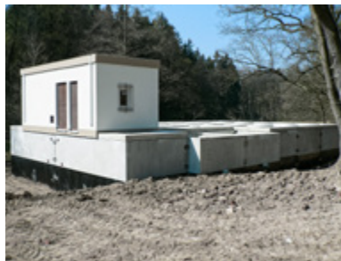
OSAZENÍ NADZEMNÍHO OBJEKTU
