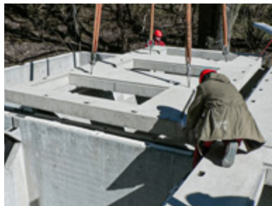
MONTÁŽ ZÁKRYTOVÝCH DESEK
