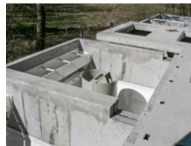
INSTALACE TECHNOLOGICKÉ ČÁSTI
