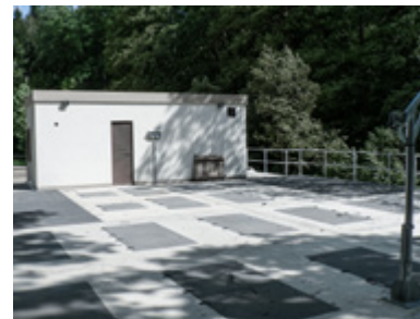
DOKONČENÁ STAVBA PŘIPRAVENÁ KE KOLAUDACI
