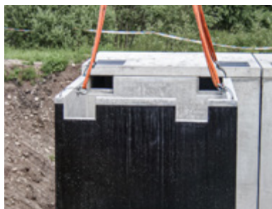
MONTÁŽ STAVEBNÍ ČÁSTI
