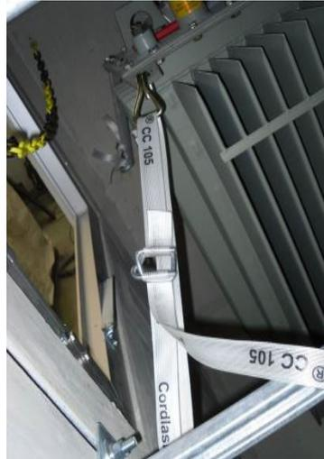
Abbildung 13: Beispiele für Ladungssicherung des Transformators in der ausgebauten Raumzelle
