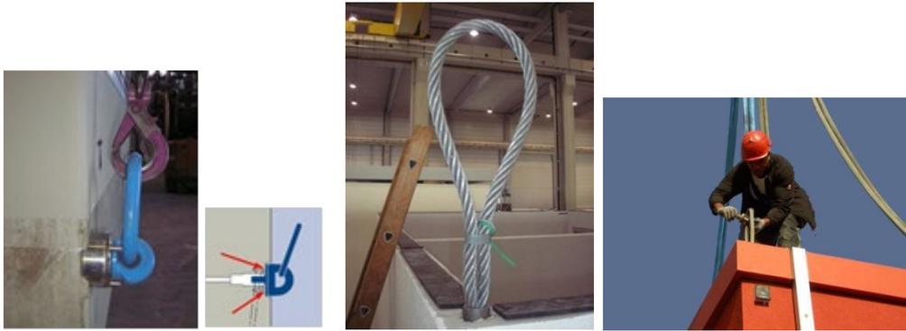
Abbildung 18: Beispiele für korrekt eingedrehte Lastaufnahmemittel
