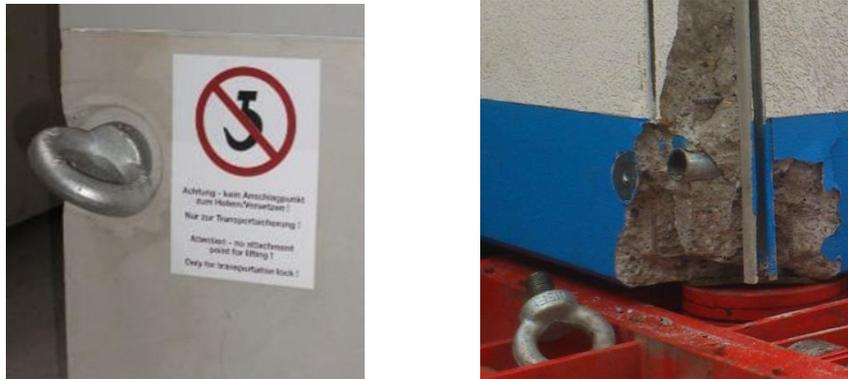
Abbildung 9: Bilder der Ladungssicherungsanker und Folgen der Falschanwendung
