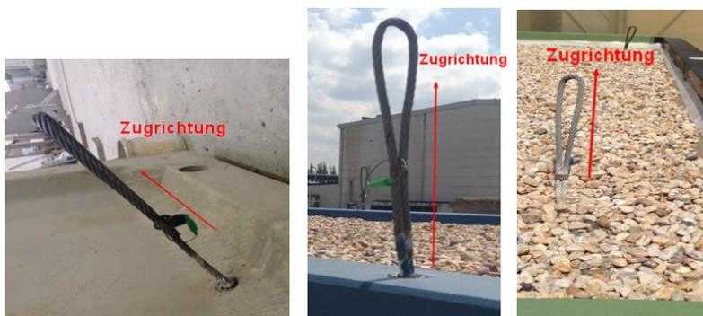
Abbildung 21: Zugrichtung der einbetonierten Transportanker
