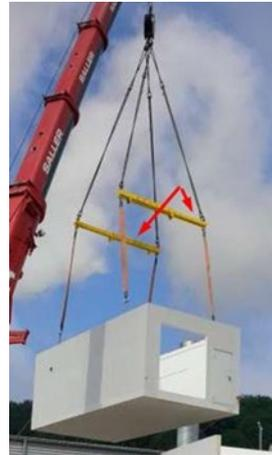
Abbildung 14+15: Versetzen mit Dach und ohne Dach
