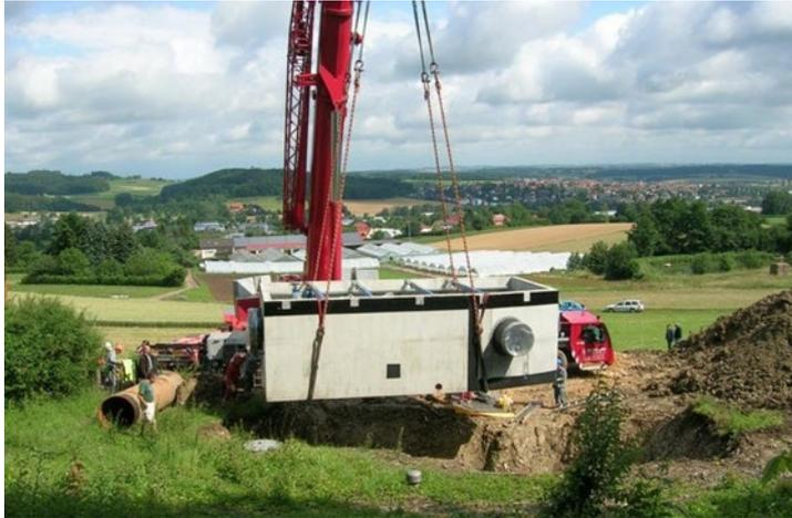
Abbildung 20: Versetzen einer Betonraumzelle mit Gurten
